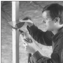
Fixer le support de montage (NB)
