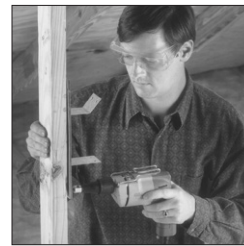
Fixer le support de montage (MB).
