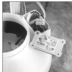
Câblage Romex - Vue de dessus
